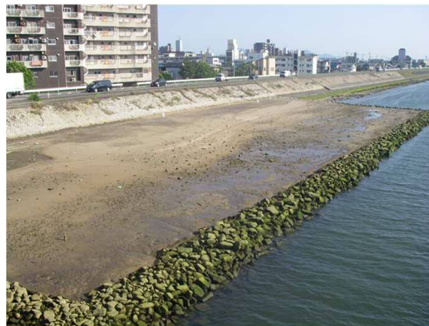
施工直後 平成 22 年 3 月
