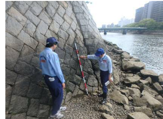
堤防点検の状況
