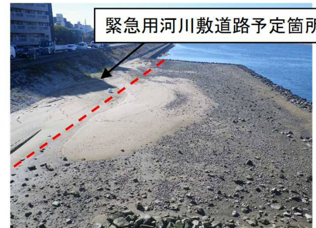
施工 8 年後 平成 30 年 7 月豪雨後
