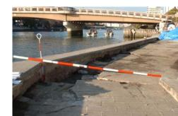
空洞化による天端の陥没(市内派川)
