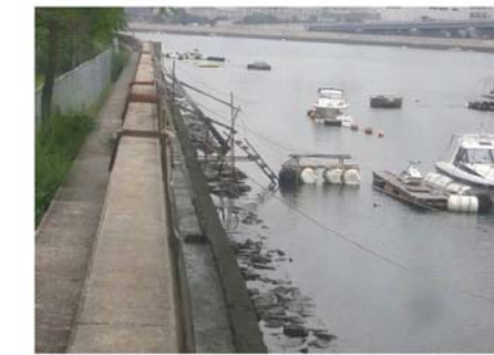
昇降梯子による河川護岸の損傷(元安川)
