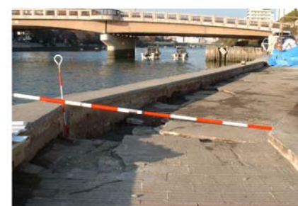
空洞化による天端の陥没(市内派川)
