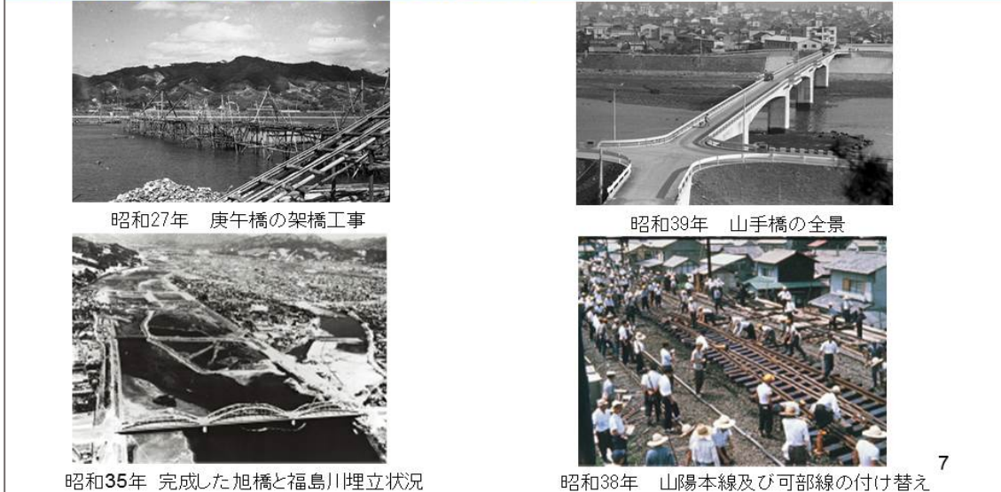
図—6 放水路工事に伴って行われた工事(2)
