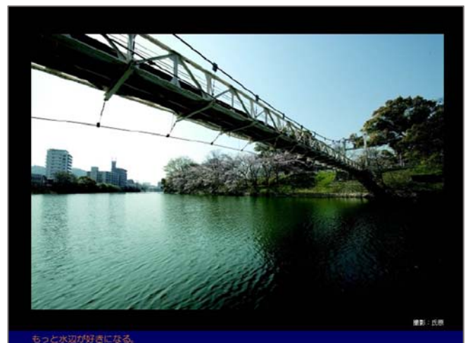
図一29 工兵橋付近
