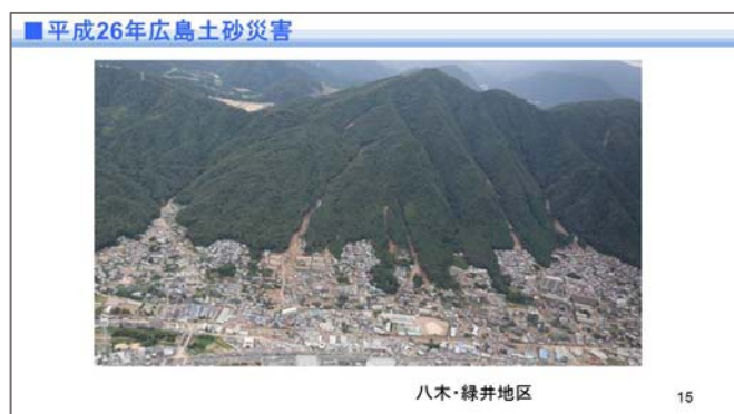
図—5 7 平成 26 年広島土砂災害
