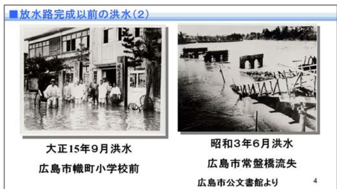
図—3 放水路完成以前の洪水(2)
