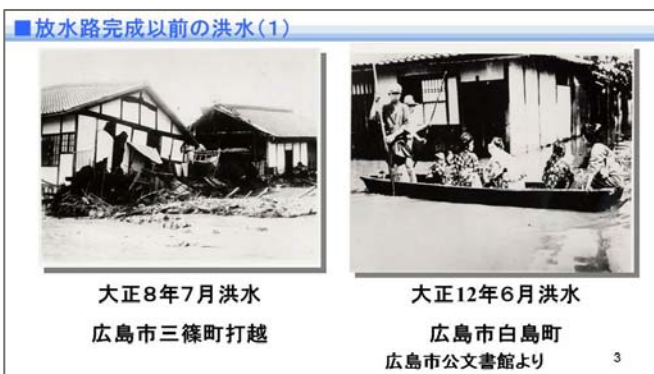
図—2 放水路完成以前の洪水(1)
