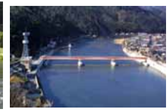
魚道が整備された中市堰
