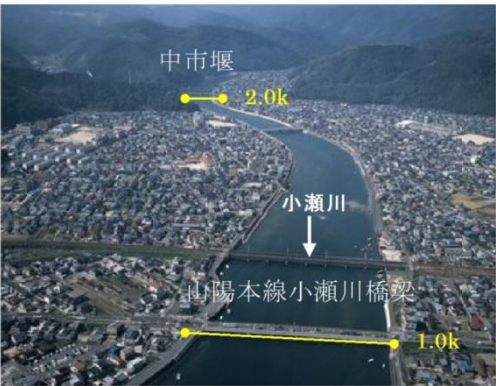
小瀬川河口地区の状況
