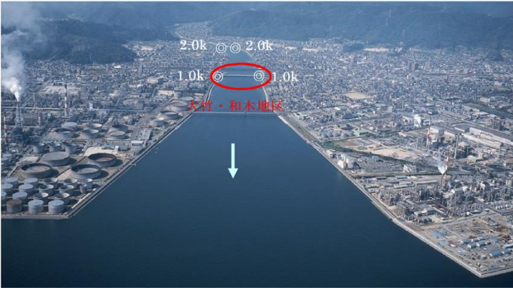
図 4.1.8 大竹・和木地区の環境整備箇所
