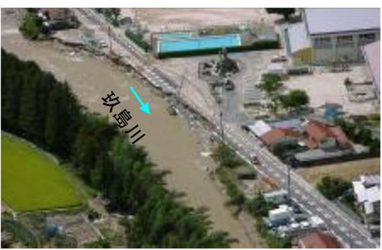
支川玖島川友和地区の河岸の被災
