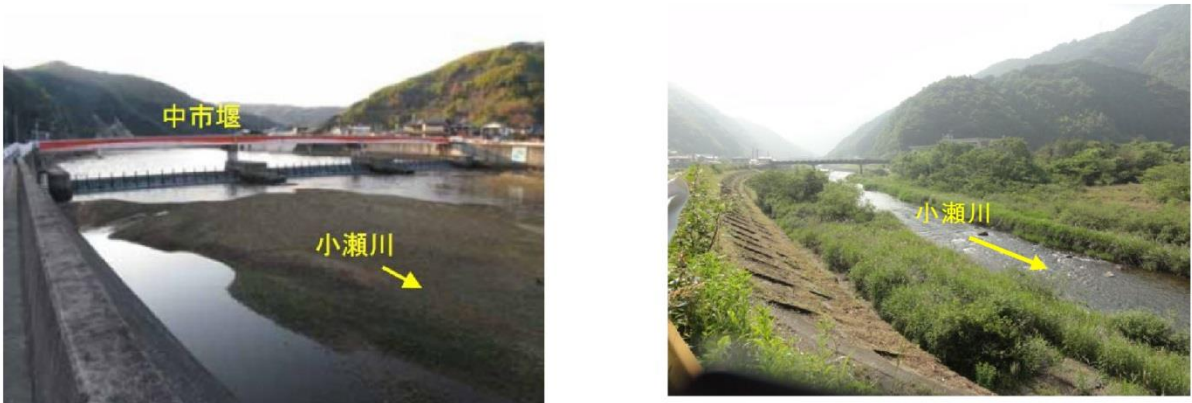
中市堰付近の土砂堆積状況（平成 22 年 1 月） 小瀬川 9.9km 付近の樹木繁茂状況
