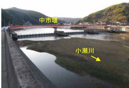
中市堰付近の土砂堆積状況（平成 22 年 1 月）
