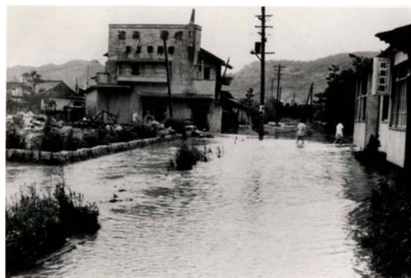
大竹町内(当時)の浸水状況
