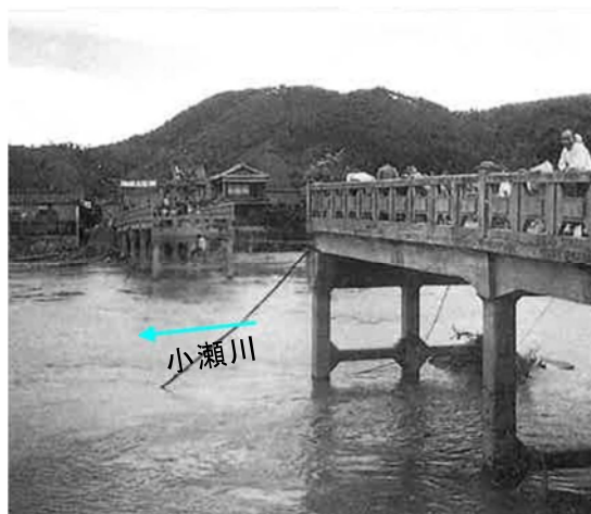
大和橋落橋の跡
