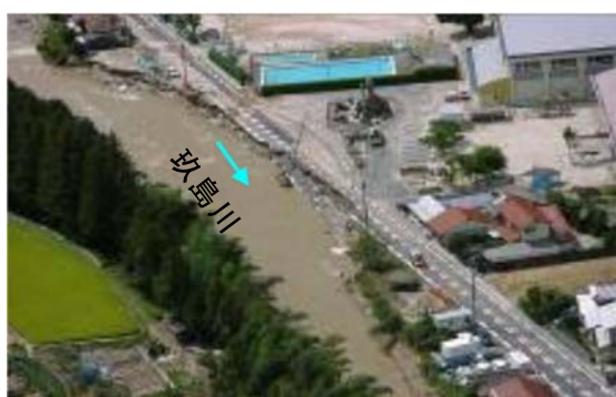
支川玖島川友和地区の河岸の被災
