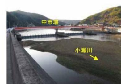
中市堰付近の土砂堆積状況（平成 22 年 1 月）
