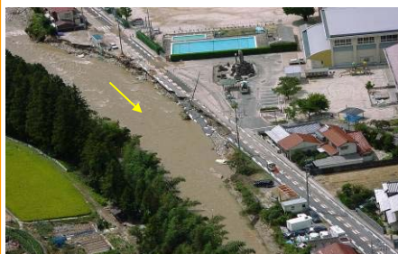
支川玖島川友和地区の河岸洗掘
