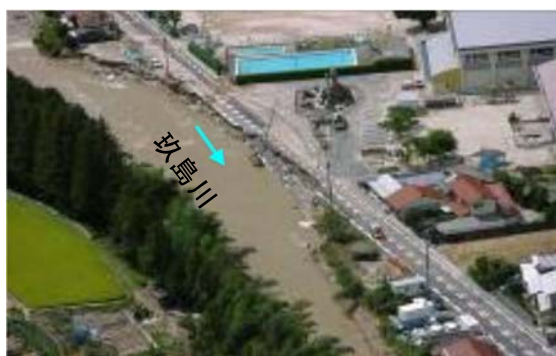
支川玖島川友和地区の河岸の被災
