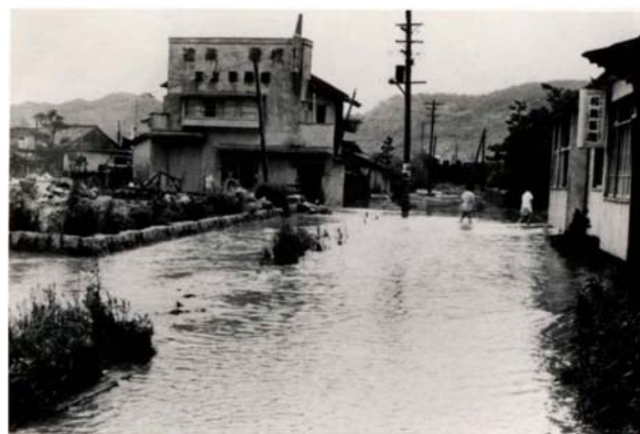
大竹町内(当時)の浸水状況
