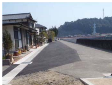
堤防天端の補修状況（元町地区）
