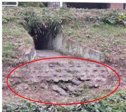
補強コンクリートの剥離
