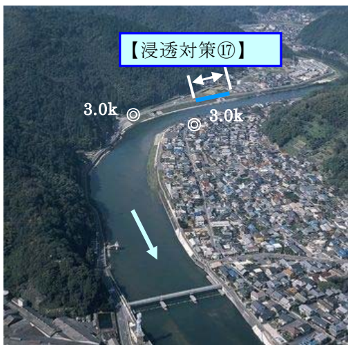
小瀬川 3.0k 付近
