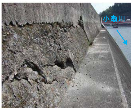
護岸の老朽化
