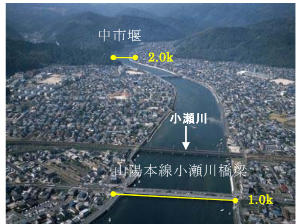
小瀬川河口地区の状況
