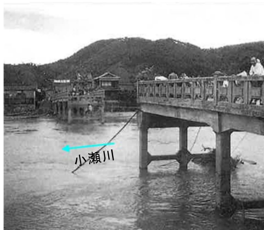
大和橋落橋の跡
