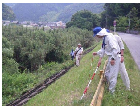
堤防点検の実施状況
