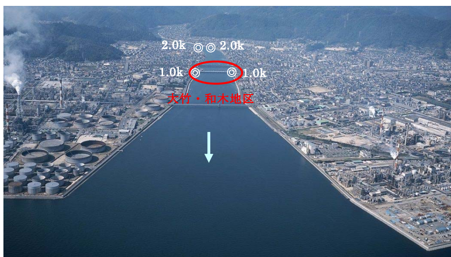
図 4.1.8 大竹・和木地区の環境整備箇所
