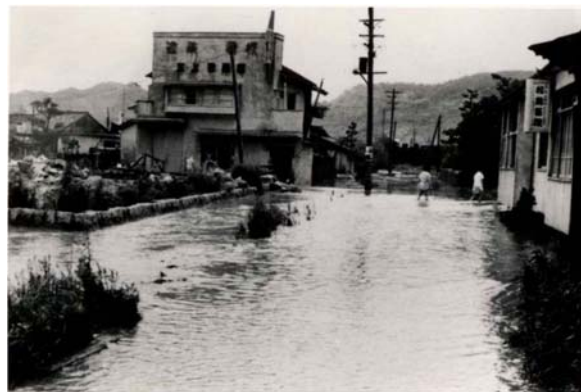
大竹町内(当時)の浸水状況
