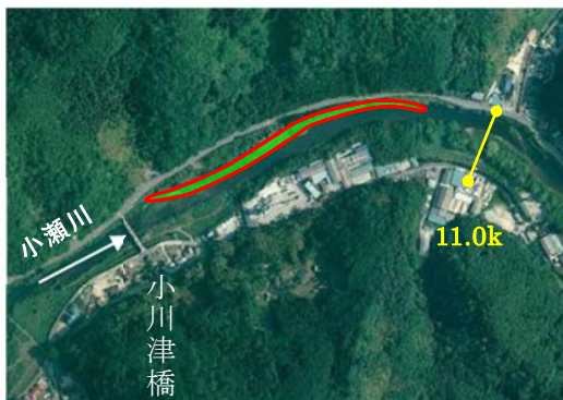
小川津橋付近の樹林化状況
