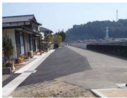
堤防天端の補修状況（元町地区）
