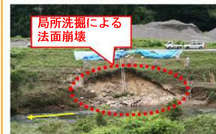
▲局所洗掘による災害状況（9k300付近）
