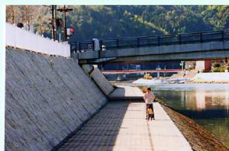
▲大和橋右岸(河川管理用通路)
