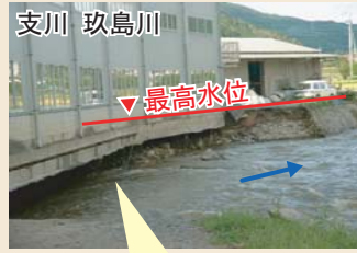
平成17年9月洪水では、水かさが増して、川岸が削られる被害が発生!
