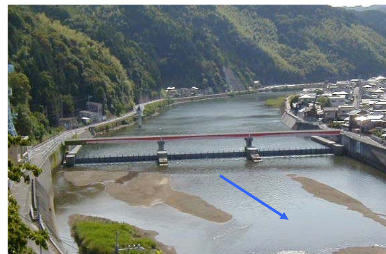
▲中市堰（平常時：ゲート起立状態）
