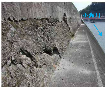
護岸の老朽化
