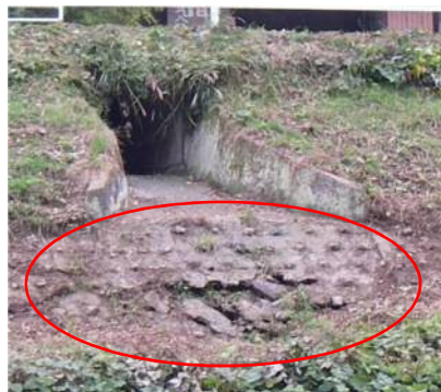
補強コンクリートの剥離
