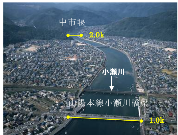
小瀬川河口地区の状況
