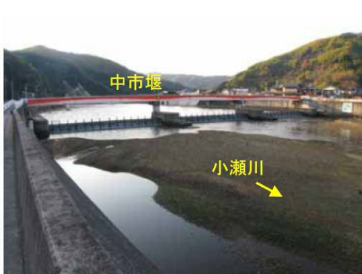
中市堰付近の土砂堆積状況（平成 22 年 1 月）
