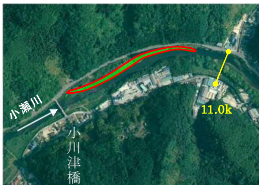
小川津橋付近の樹林化状況
