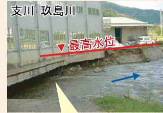
平成17年9月洪水では、水かさが増して、川岸が削られる被害が発生!
