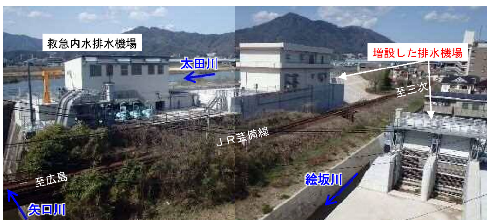
図-4.6.2 矢口川と排水機場
