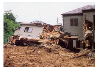
土石流による被害状況
