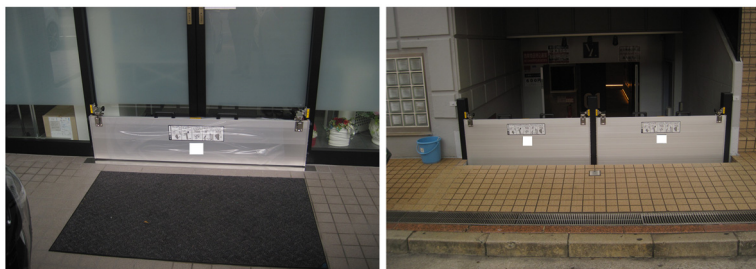
止水板の設置状況
