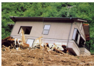
土石流による被害状況（民家流出）
