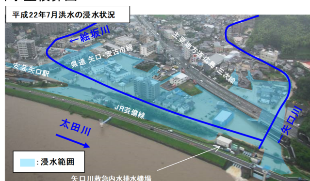
図-4.1.6 平成 22 年 7 月洪水による浸水状況
