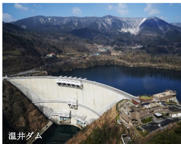
図-8.3.1 温井ダムの諸元及び写真
