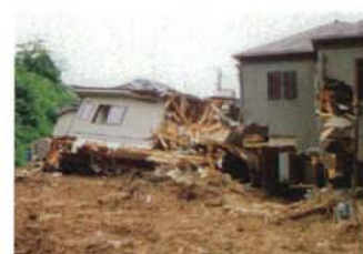
土石流による被害状況
