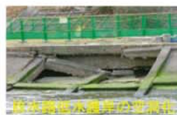
放水路通水護岸の老朽化
