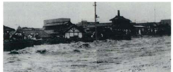
昭和 47 年 7 月豪雨 根谷川出水状況
