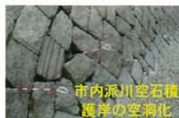
放水路通水護岸の老朽化
