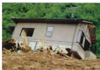
土石流による被害状況(民家流出)
