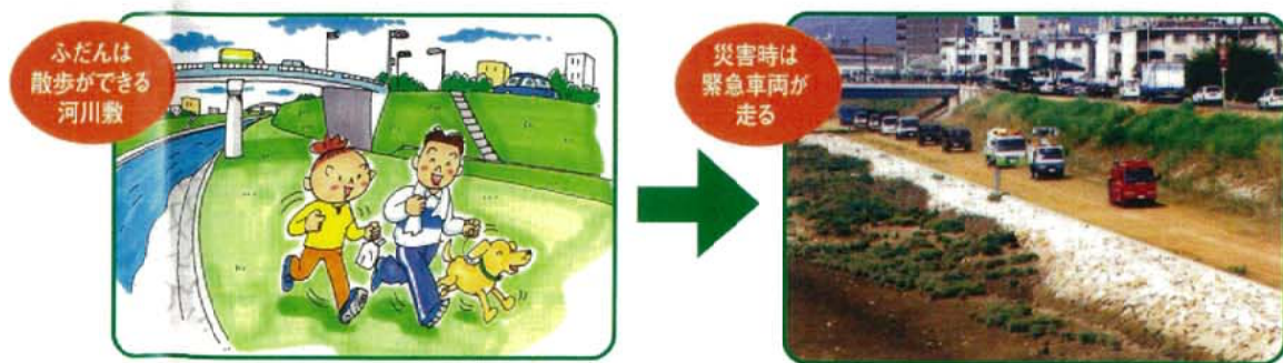
図-9.4.3 緊急用河川敷道路
