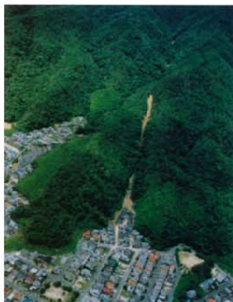
安川左支川の土石流氾濫状況
