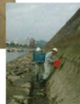
堤防の空洞化調査
