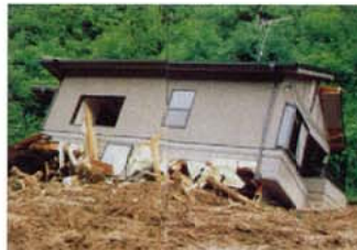
土石流による被害状況 (民家流出)
