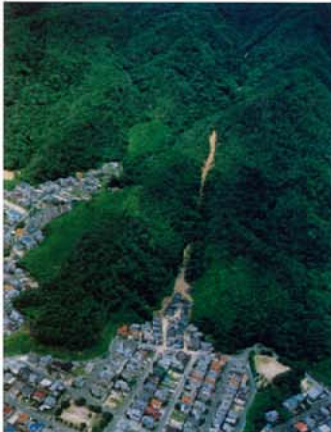
安川左支川の土石流氾濫状況
