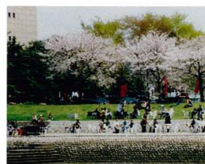
基町環境護岸(玉石護岸・桜並木)
