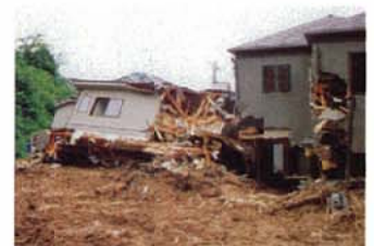
土石流による被害状況
