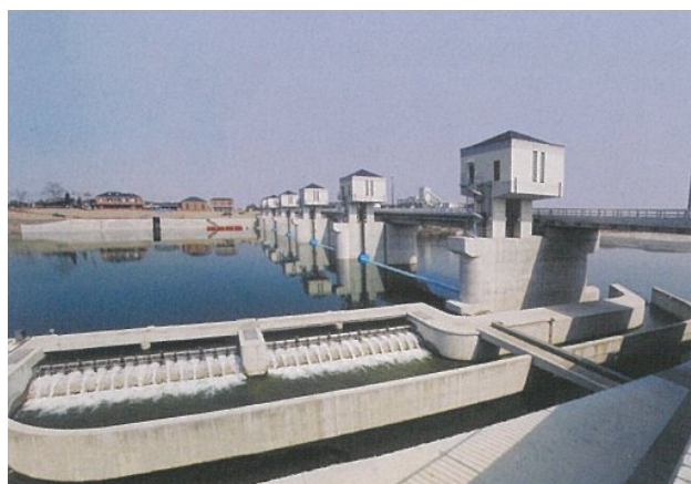
写真 5-4 六堰頭首工と流水改善水路（手前）
