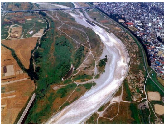
写真 5-5 熊谷付近の瀬切れの状況 (平成4年)
