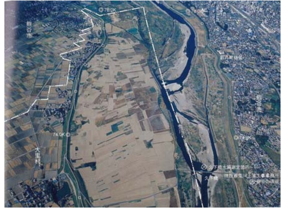
写真 8-5 久下橋（74.0k 付近）
