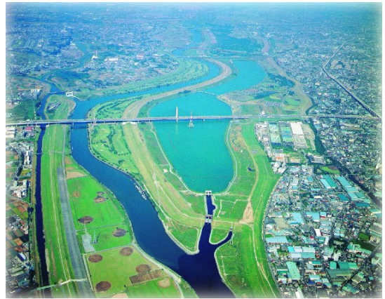
写真 9-4 荒川第一調節池
