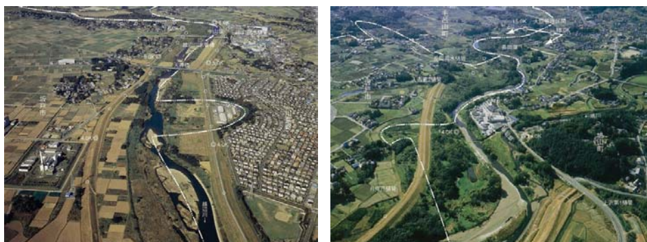
写真 8-14 直轄管理区間の越辺川（左：下流部、右：上流部）
