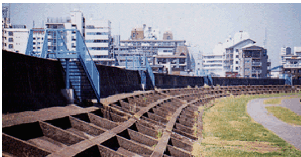
写真 4-20 荒川の高潮堤防
