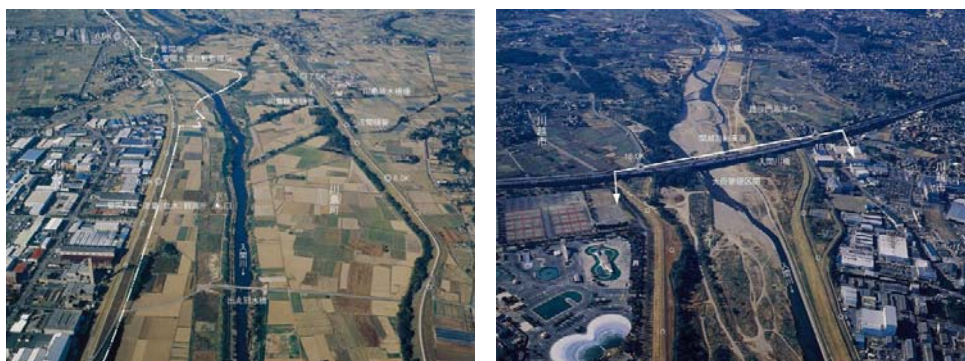
写真 8-13 直轄管理区間の入間川（左：下流部、右：上流部）
