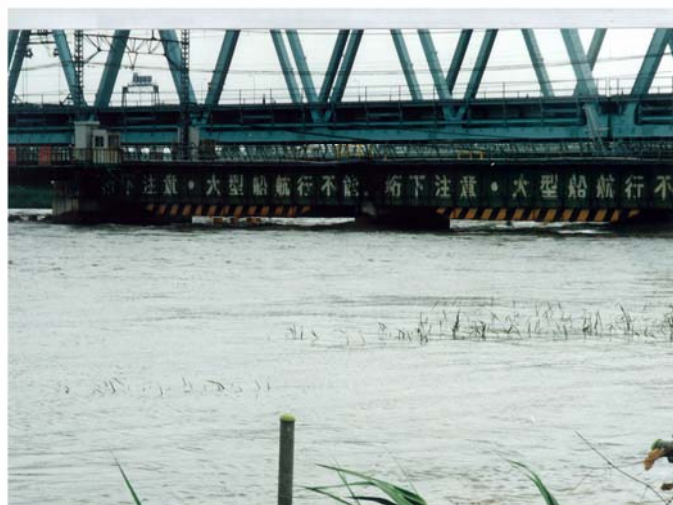
写真 4-12 形成押上線橋梁の洪水写真
