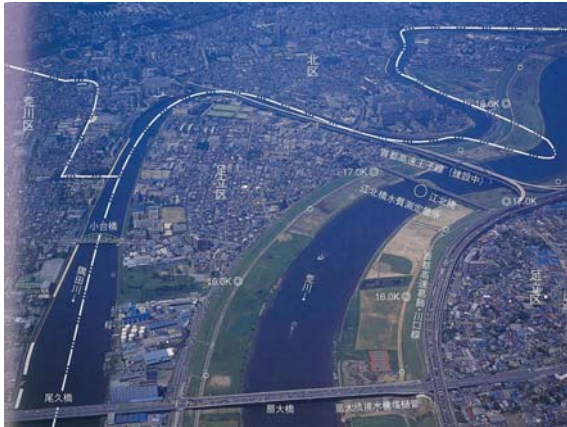
写真 8-9 扇大橋 (15.0k 付近)
