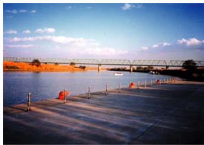
水上輸送の拠点となるリバーステーション (秋ヶ瀬リバーステーション)
