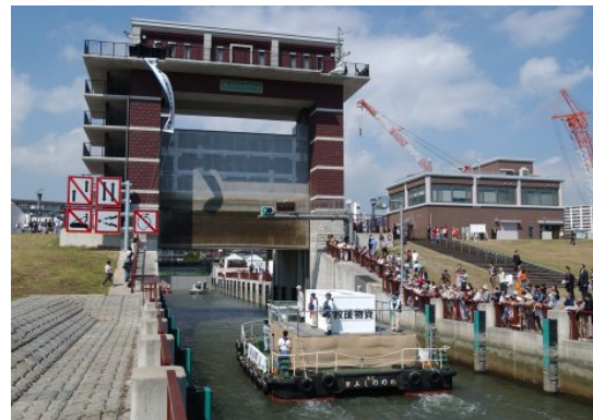
写真 7-6 荒川ロックゲート
