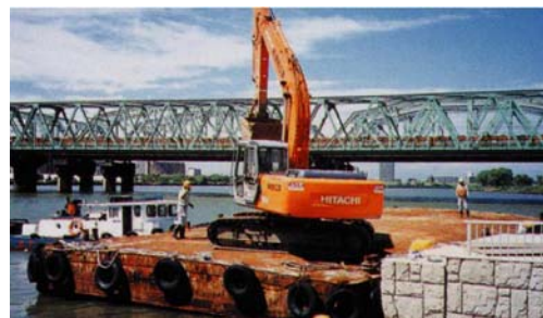
リバーステーションからの重機搬入 (川口リバーステーション)
