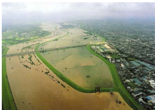
写真 4-10 荒川第一調節池
