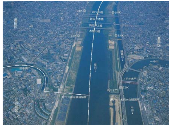
写真 8-8 京成押上線下流 (7.0k 付近)
