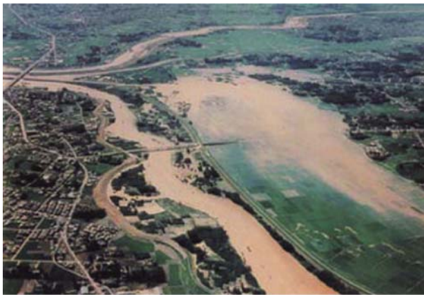
写真 4-7 三川合流部（入間川、越辺川、小畔川）
