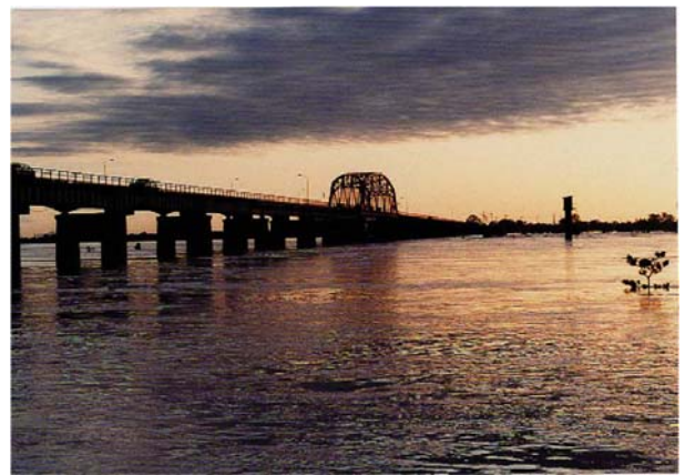
写真 4-8 治水橋（さいたま市）
