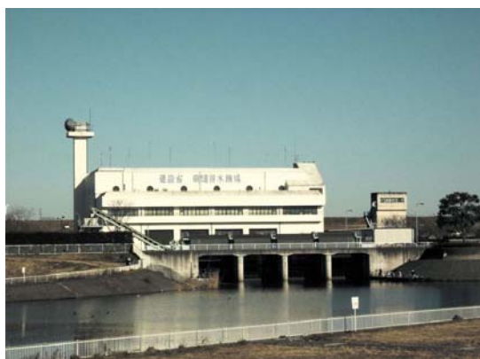
写真 4-13 南畑排水機場
