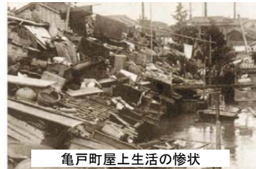
亀戸町屋上生活の惨状
