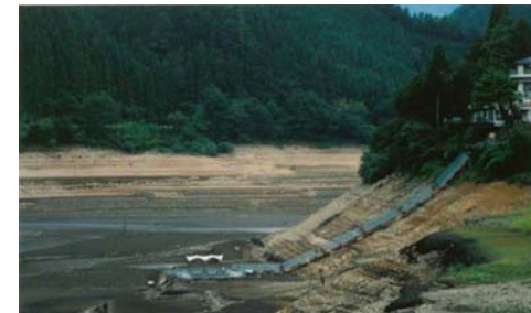
干上がった引原ダム (平成6年9月14日)
