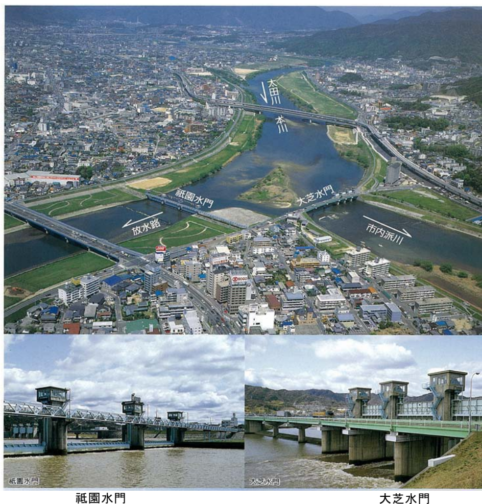
図 2.2.7 現在の分派地点の状況
