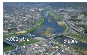
現在の分派地点の状況
