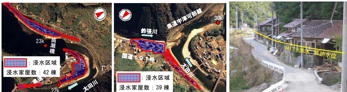
22. 0k～23. 3k 筒瀬川合流点上流付近（広島市安佐北区安佐町大字筒瀬地先） 22. 0k～23. 3k 筒瀬川合流点上流付近（広島市安佐北区今井田地先） 30. 4k～30. 8k 鈴張川合流点付近（広島市安佐北区安佐町大字飯室地先） 被災痕跡水位（広島市安佐北区安佐町大字久地地先）
