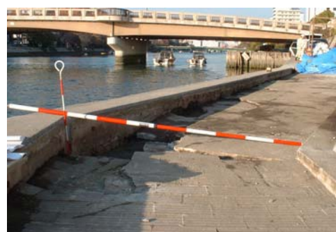
空洞化による天端の陥没(市内派川)
