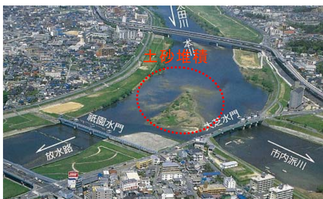
分派地点の土砂堆積状況
