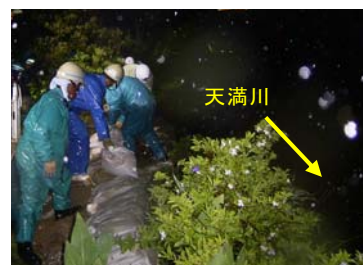
観音地区の土のう積み状況
