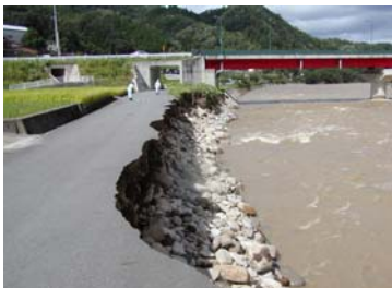
山県郡安芸太田町大字上殿地先
