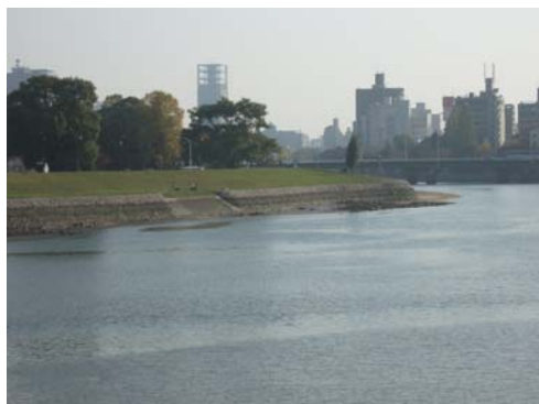
基町環境護岸（下流デルタ域）
