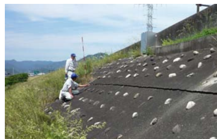
堤防点検の状況
