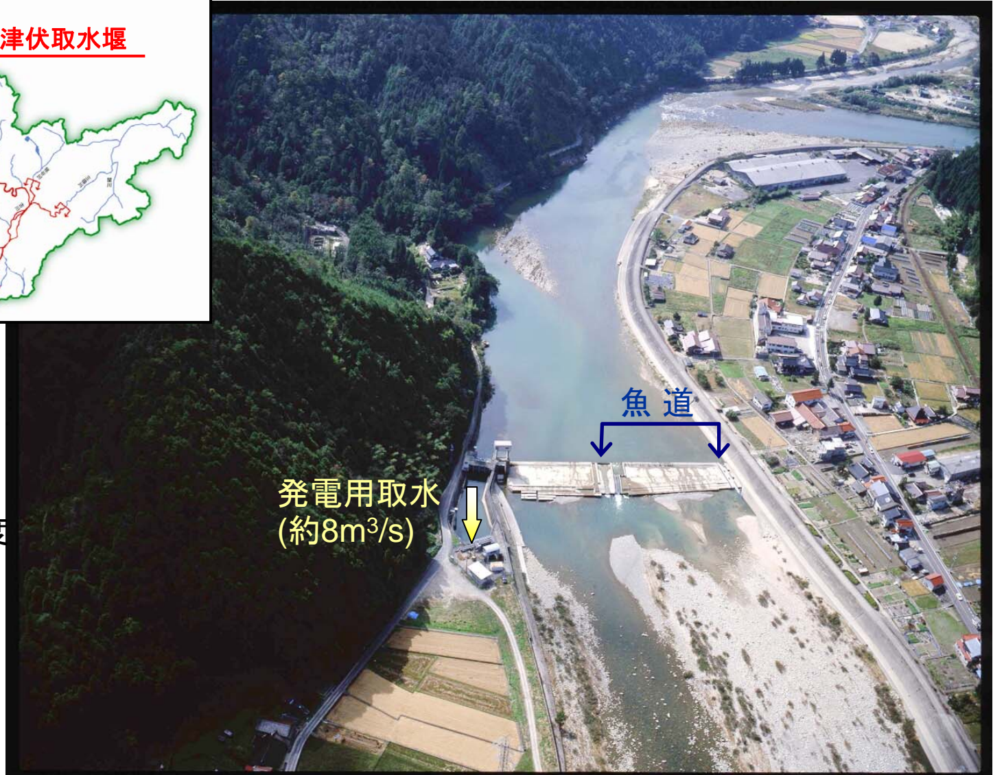
津伏取水堰周辺
