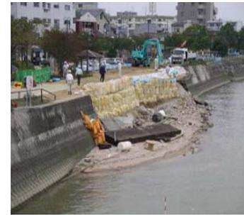
高潮と波浪(H16.9台風18号)により崩壊した高潮堤防を、被災後すぐに応急復旧に着手し、被災10時間後という短時間で、応急復旧を完了。
