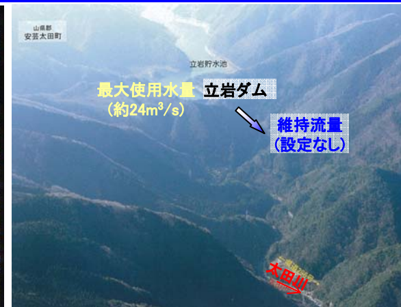
ガイドラインによる維持流量が設定されていない立岩ダム
