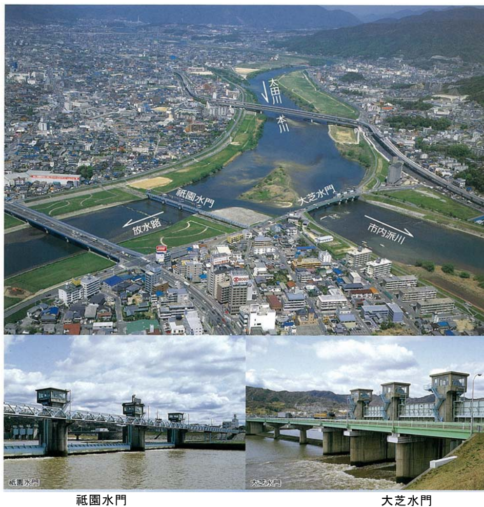
図 2.2.7 現在の分派地点の状況
