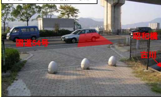
国道54号(昭和橋)の状況
