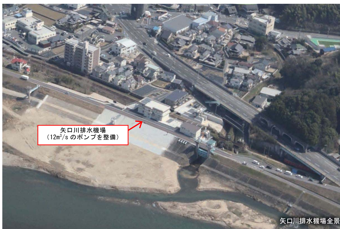
矢口川排水機場
