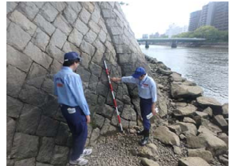
堤防点検の状況
