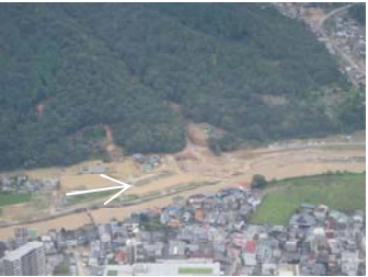
図 3.1.20 安佐北区可部東地区の被害状況
