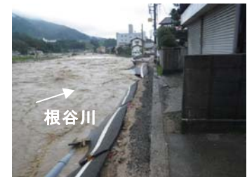
根谷川 平成26年8月豪雨時の様子 (安佐北区可部地区)
