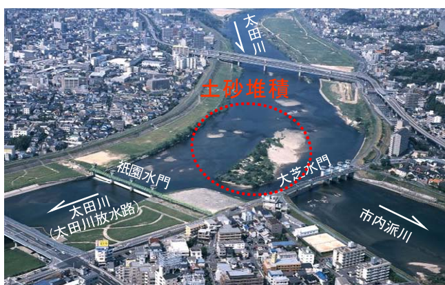
分派地点の土砂堆積状況
