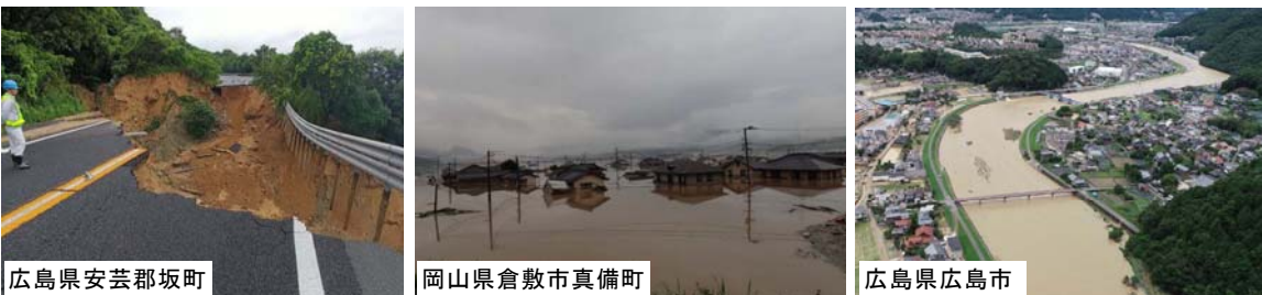
図 3.1.23 平成 30 年 7 月豪雨の被害状況
