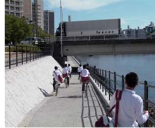
北大橋左岸のアンダーパス
