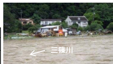
図 3.1.25 三篠川右岸 3k000 付近の溢水
