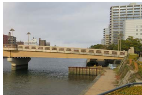
空洞化対策実施後(市内派川)
