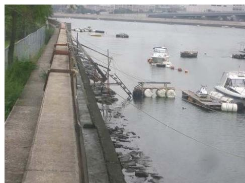
25 昇降梯子による河川護岸の損傷(元安川)
