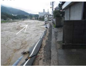
図 3.1.17 安佐北区可部地区の被害状況
