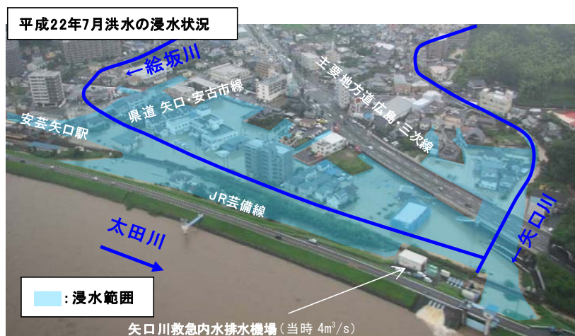
図 2.2.9 平成 22 年 7 月洪水による浸水状況
