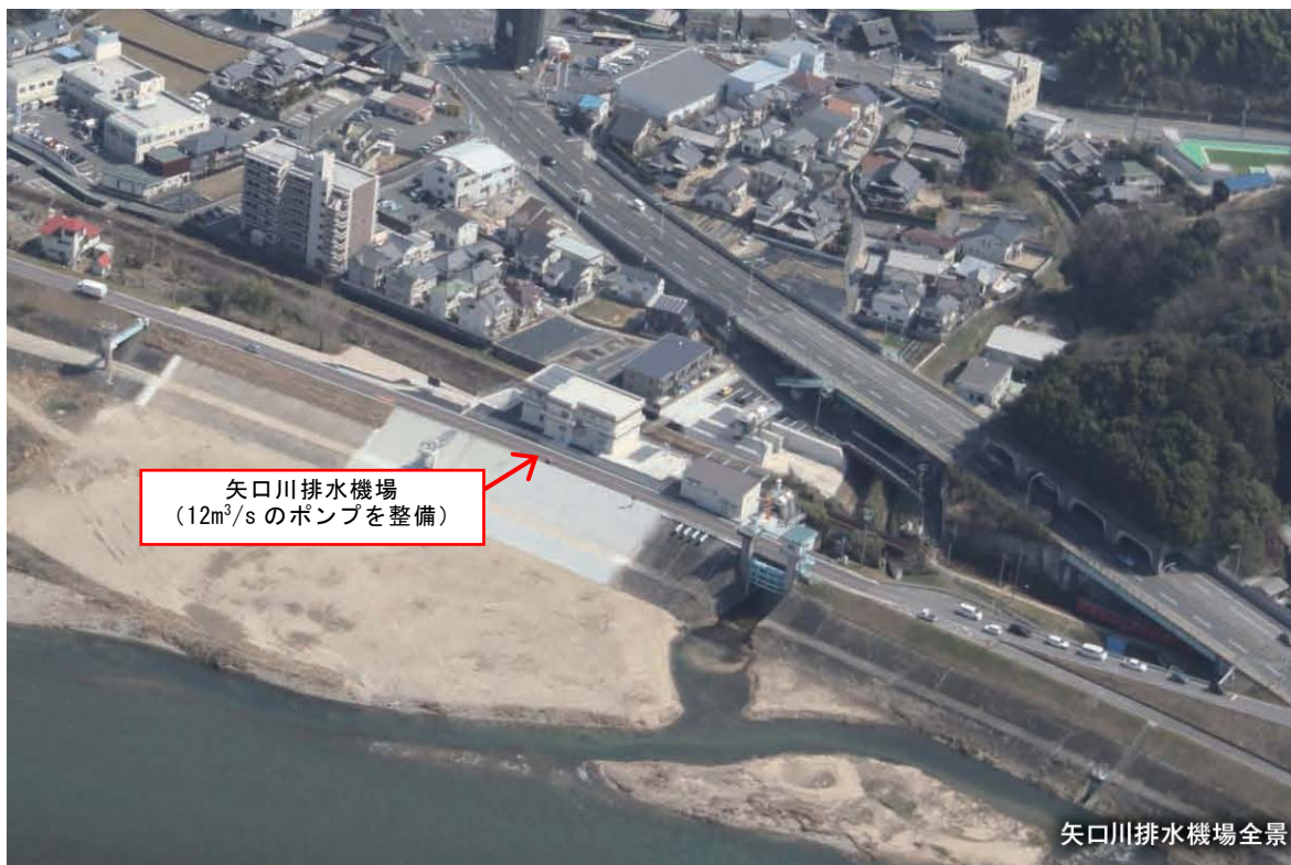
矢口川排水機場
