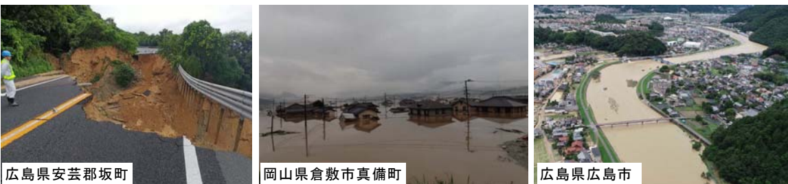
図 3.1.21 平成 30 年 7 月豪雨の被害状況
