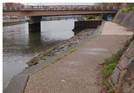
空洞化対策実施後(市内派川)
