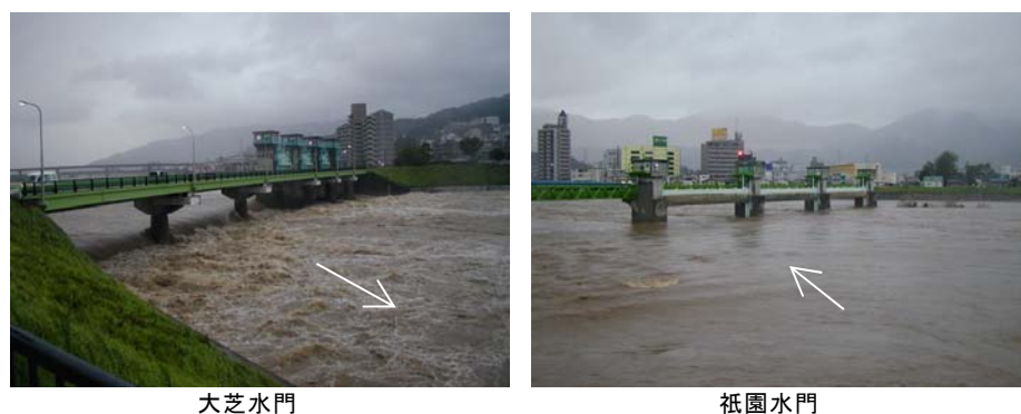
図 3.1.12 平成 17 年 9 月洪水時の大芝水門、祇園水門の状況
