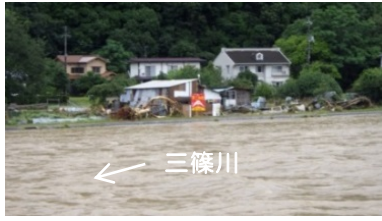
図 3.1.23 三篠川右岸 3k000 付近の溢水
