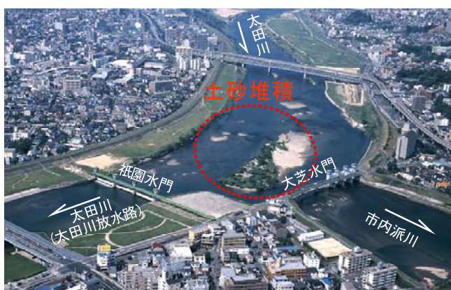
分派地点の土砂堆積状況
