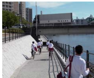
北大橋左岸のアンダーパス
