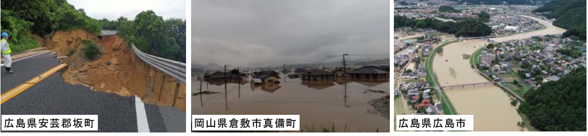
図 3.1.21 平成 30 年 7 月豪雨の被害状況
