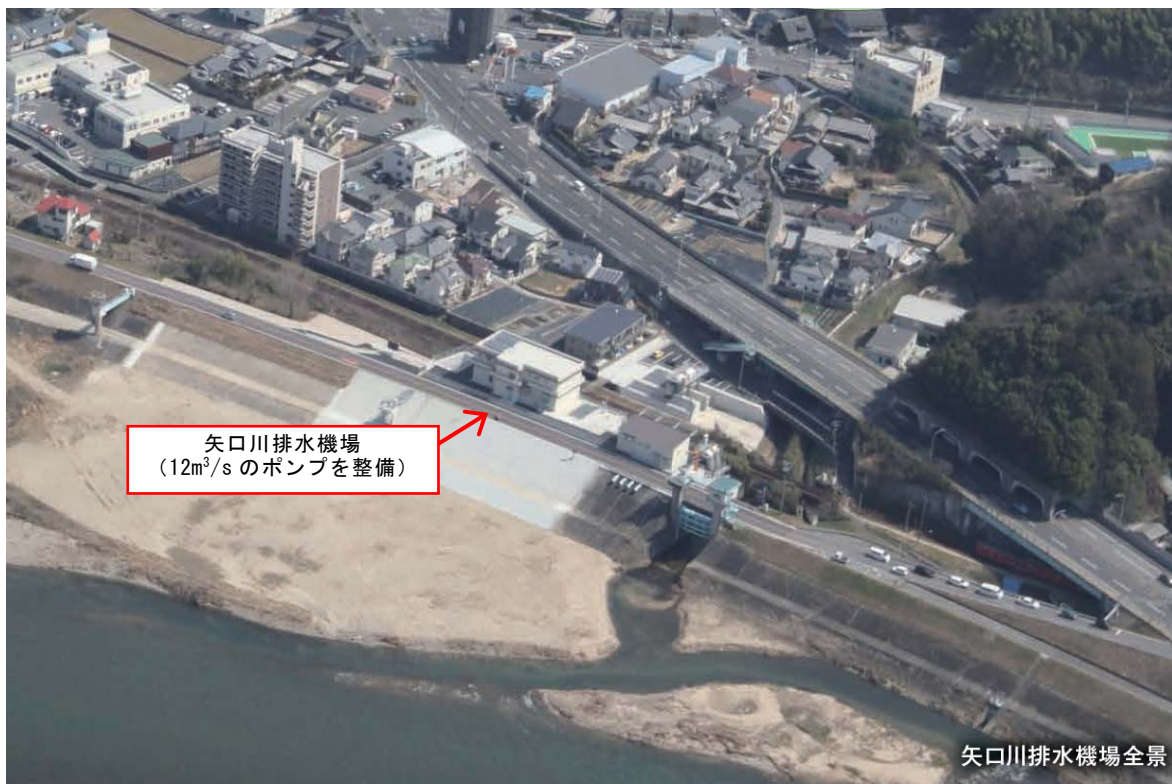
矢口川排水機場
