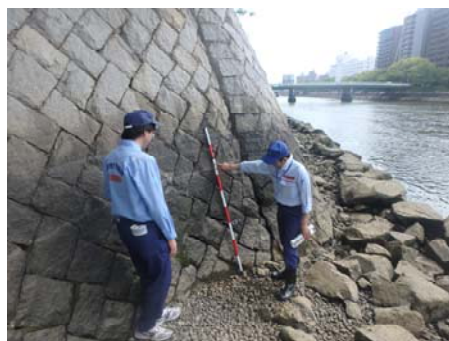
堤防点検の状況
