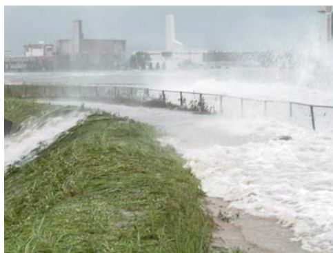
平成16年 9月高潮による浸水状況 (広島市西区観音付近)
