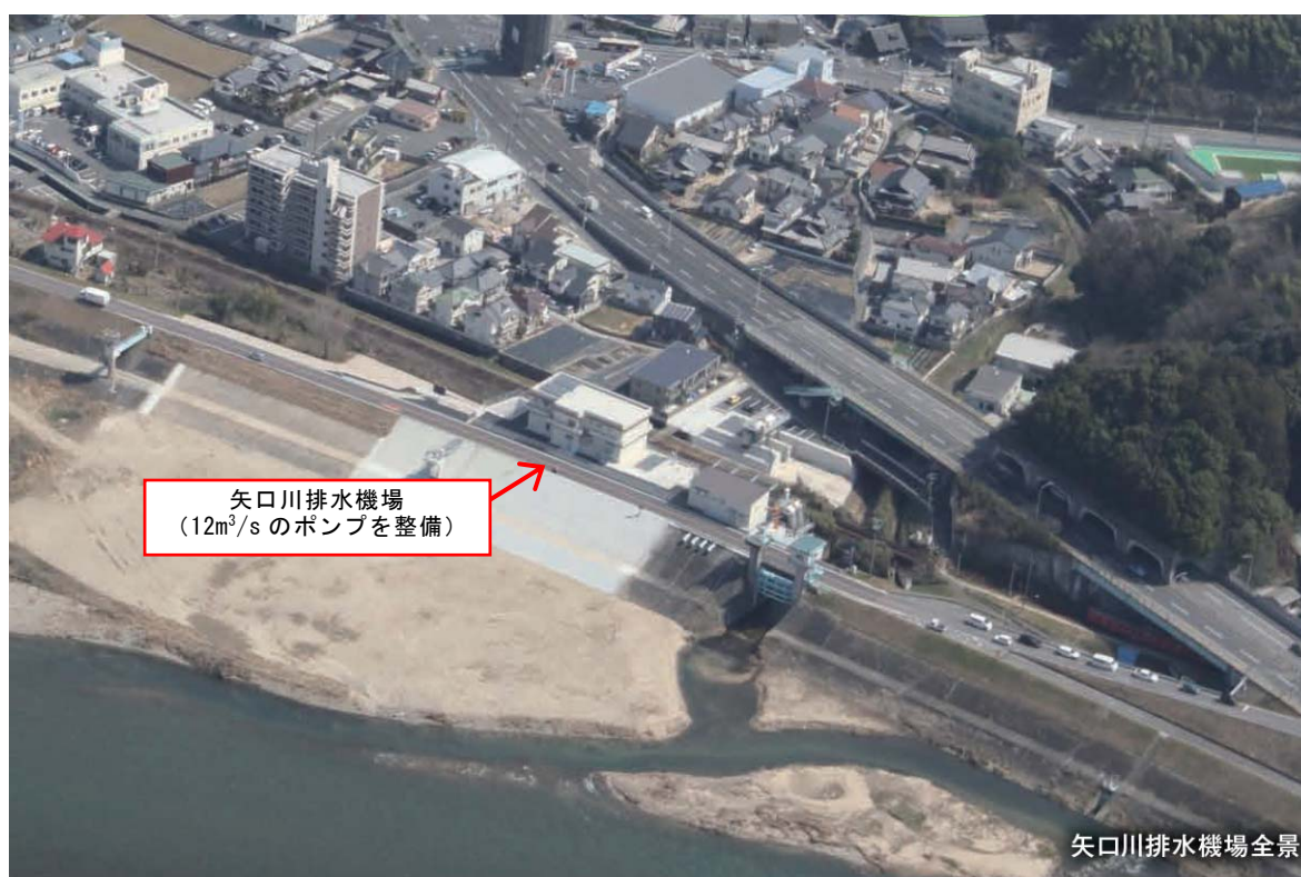
矢口川排水機場
