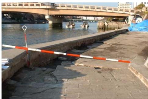
空洞化による天端の陥没(市内派川)
