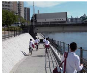
北大橋左岸のアンダーパス
