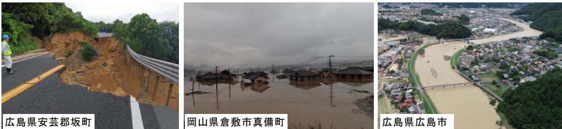
図 3.1.25 平成 30 年 7 月豪雨の被害状況
