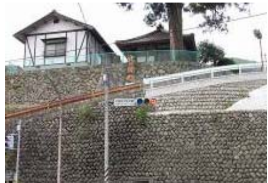
太田川中上流部で見られる玉石を用いた石垣
