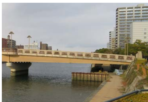
空洞化対策実施後(市内派川)
