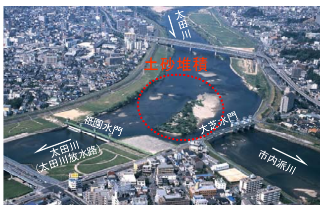
分派地点の土砂堆積状況
