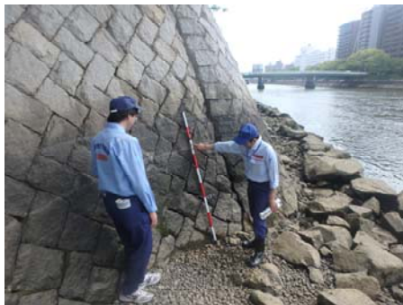
堤防点検の状況
