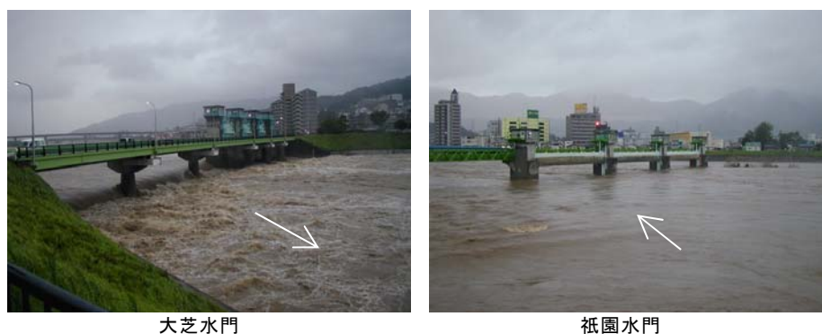
図 3.1.16 平成 17 年 9 月洪水時の大芝水門、祇園水門の状況
