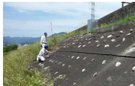
堤防点検の状況
