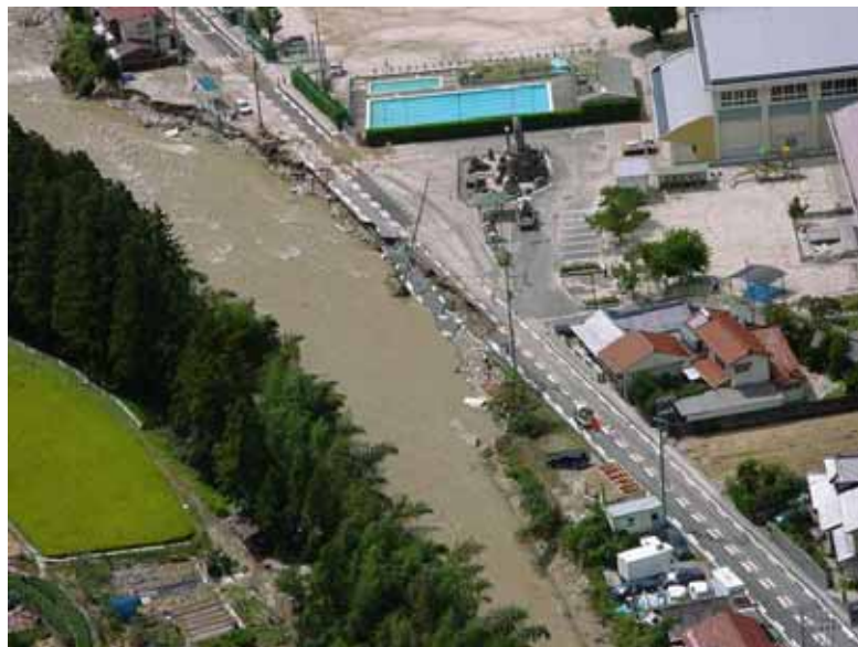
玖島川の被災状況(広島県廿日市市)
