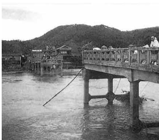
大和橋落橋の跡
