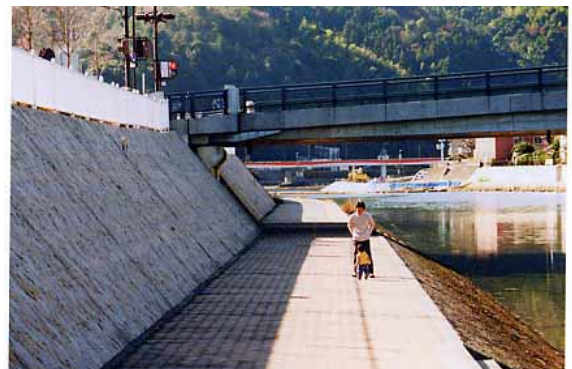
大和橋右岸アンダーパス(散策道)
