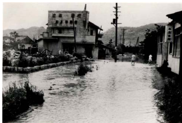
大竹町内(当時)の浸水状況
