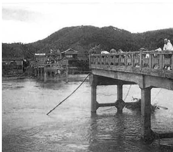
大和橋落橋の跡
