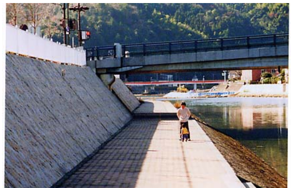
大和橋右岸アンダーパス(散策道)
