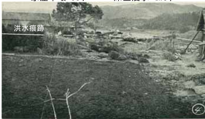
写真4-1 昭和29年9月洪水被害状況（高鍋町）
