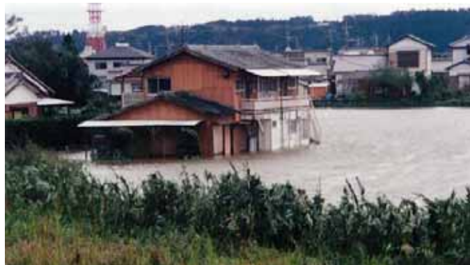
写真4-2 平成9年9月洪水被害状況（高鍋町）
