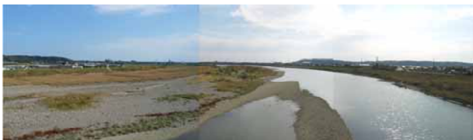
写真 8-4 高鍋大橋より小丸川下流を望む
