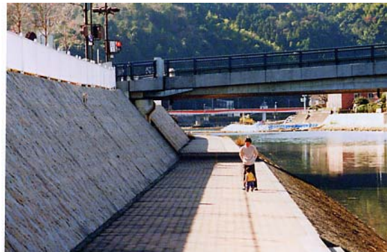
大和橋右岸アンダーパス(散策道)
