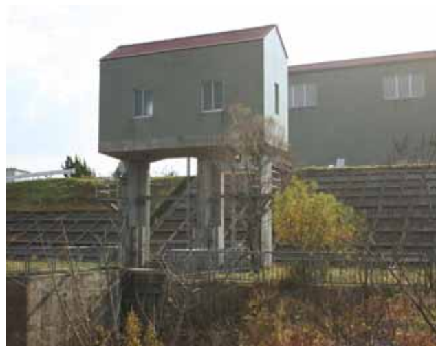
写真 4-83 柿川排水機場
