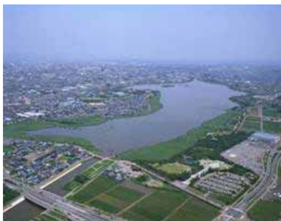
写真 8-1 現在の鳥屋野潟の状況
