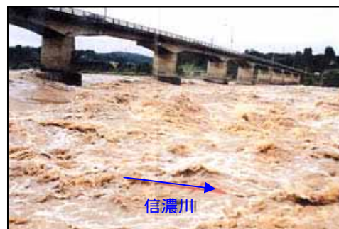
写真 4-41 十日町橋の状況
