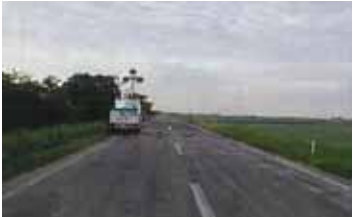
写真 5-20 野中才(下流)堤防復旧工事
