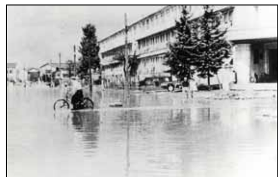
写真 4-11 柿川流域の浸水状況 (旧日赤病院前)
