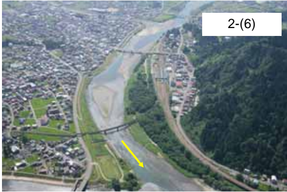
魚野川破間川合流点付近【H18 撮影】
