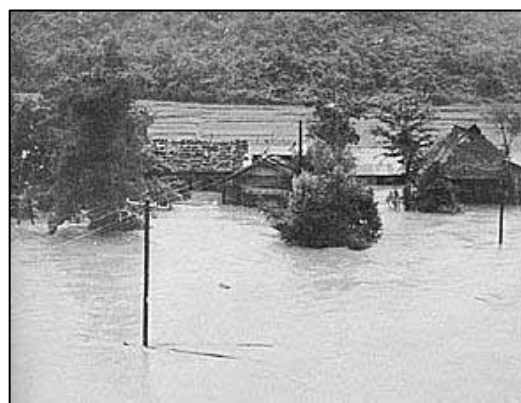
写真 4-20 旧下田村小外谷地区(鹿熊川)
