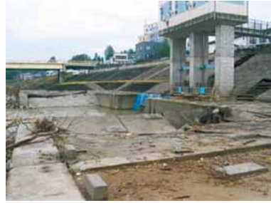
小千谷市千谷川 低水護岸破
