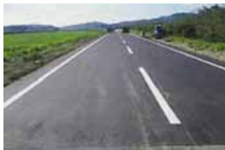
写真 5-19 野中才(上流)堤防復旧工事
