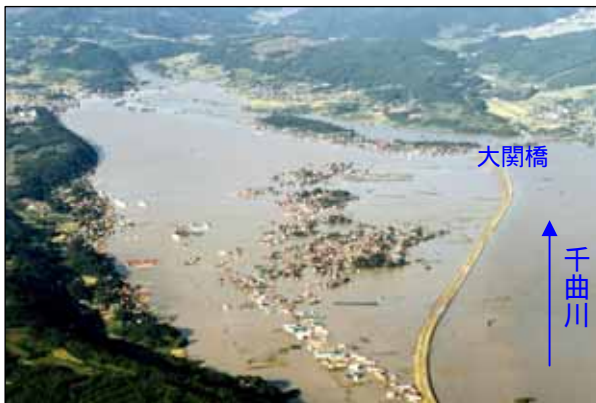
写真 4-38 昭和 58 年 9 月台風 10 号による出水状況
