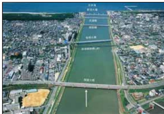
写真 4-90 関屋分水路(現在)
