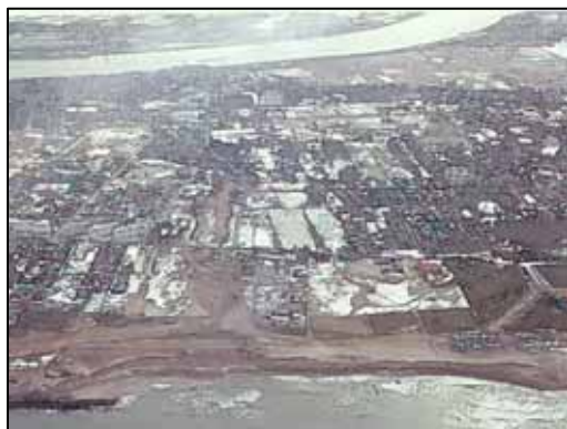
写真 4-89 関屋分水路着工(昭和 43 年 2 月)
