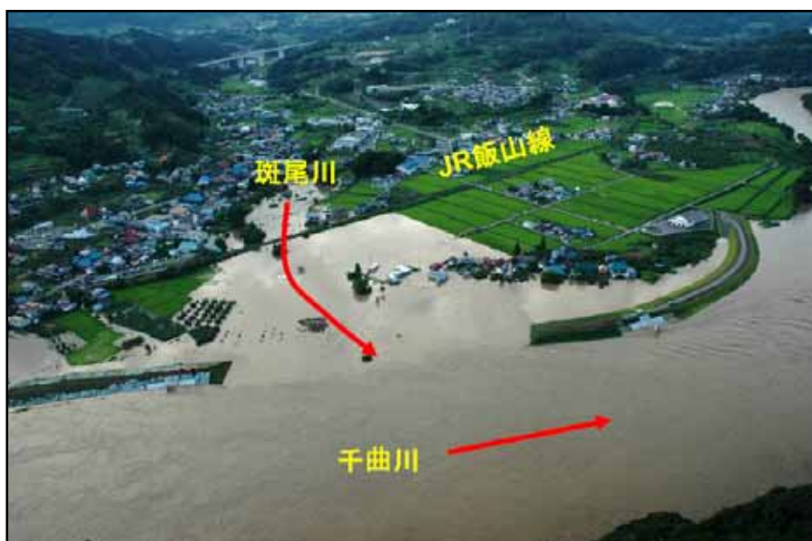
写真 4-49 中野市替佐地区(堤防整備中)の浸水状況
