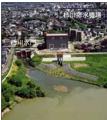
写真 11-8 柿川排水機場
