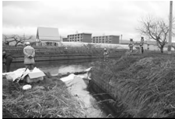
図 11-10 オイルフェンス・吸着マットによる油除去作業（須坂市）
