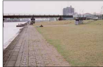
写真5-9 やすらぎ堤整備後
