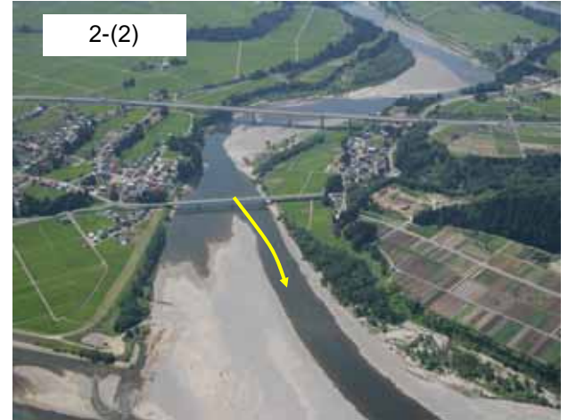
河岸段丘（関越自動車道橋梁付近）【H18 撮影】
