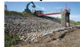
写真 5-22 町軽井堤防復旧工事
