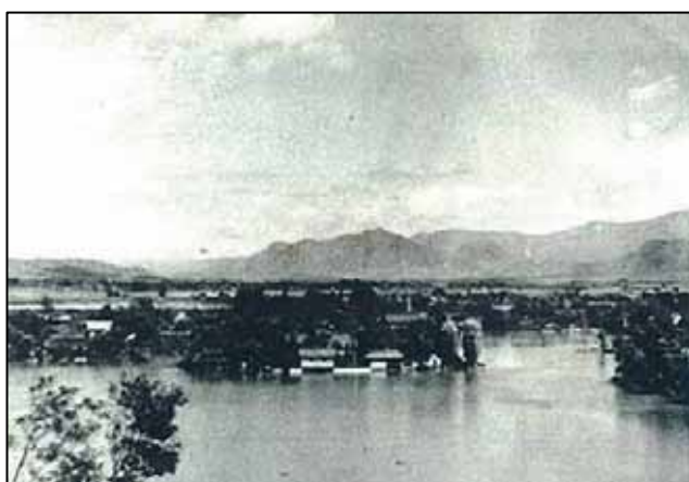
写真 4-6 旧真島村の浸水状況
