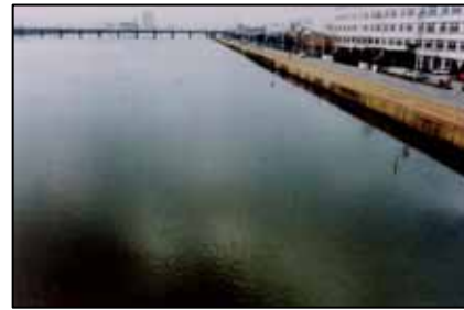
写真5-8 災害復旧後の堤防
