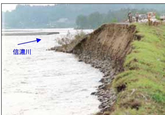
写真 4-34 十日町高島地先での堤防欠壊状況
