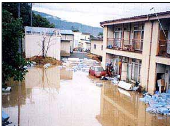
写真 4-42 旧更埴市浸水状況
