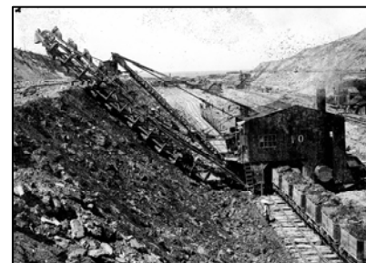
写真 4-64 大河津分水路開削工事実施状況
