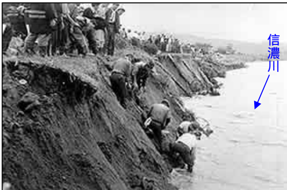
写真 4-16 長岡水梨地区の堤防欠壊状況
