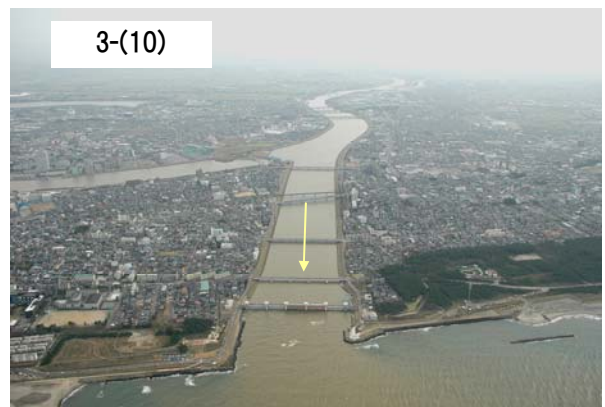
関屋分水路河口
