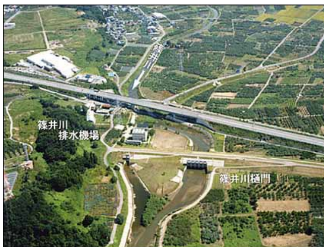
写真 11-9 内水対策（篠井川排水機場） （出典：千曲川パンフレット 千曲川河川事務所）
