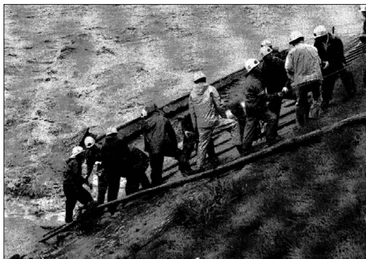
写真 4-30 大屋地先の流失箇所の水防の様子
