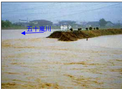
写真 4-43 五十嵐川の破堤状況
