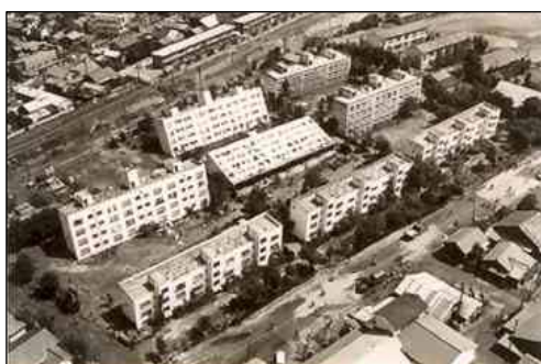
写真5-1 液状化により傾いた県営アパート
