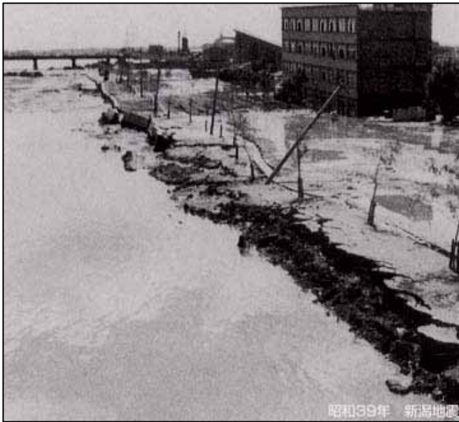
写真5-7 地震と津波により流出した堤防
