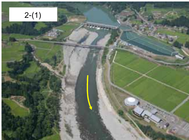
JR 宮中取水ダム付近【H18 撮影】
