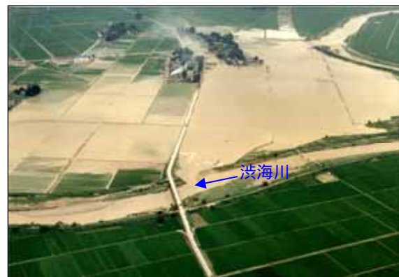
写真 4-25 渋海川破堤状況
