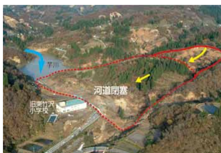
写真5-13 山古志村東竹沢地区の河道閉塞発生状況
