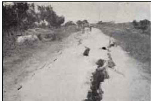
写真5-10 横田地先の堤防亀裂
