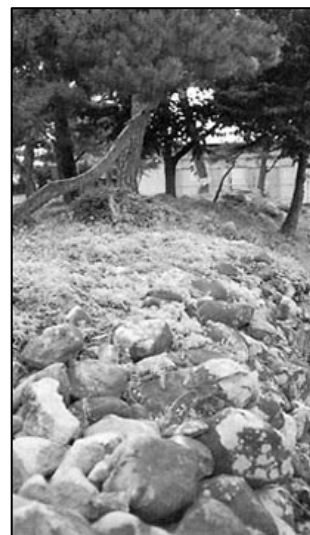
写真 4-52 太夫の千両堤の跡 上高井郡小布施町上松川
