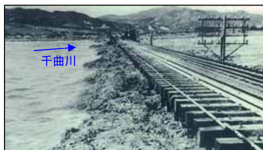
写真 4-12 信越線篠ノ井鉄橋での出水状況
