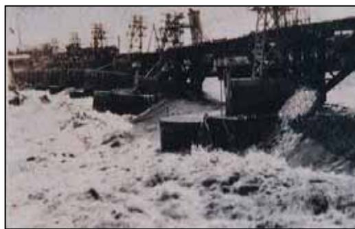
写真 4-65 陥没した自在堰 (出典：信濃川河川事務所資料)
