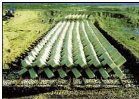
写真 4-73 導流堤設置状況 幅 20m の粗朶沈床の上に 2t の異形ブロックを幅 12m で三層積み
