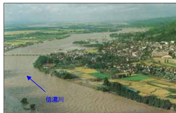
写真 4-35 東小千谷地区旭橋の状況
