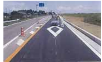
写真 5-21 町軽井堤防復旧工事
