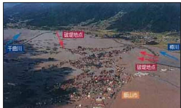
写真 4-33 樽川の破堤状況
