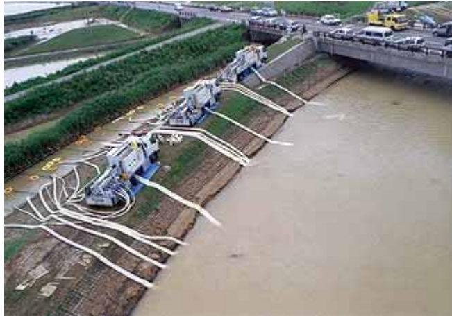
図 11-6 排水ポンプ車による排水の状況
