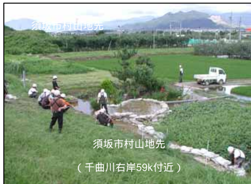
平成18年7月洪水堤防漏水状況
