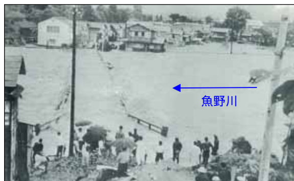
写真 4-10 魚野川 柳生橋付近の様子
