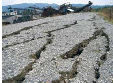
小千谷市川井 無数の縦断亀裂
