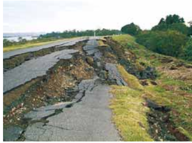
長岡市三俣野 大規模崩壊、天端亀裂
