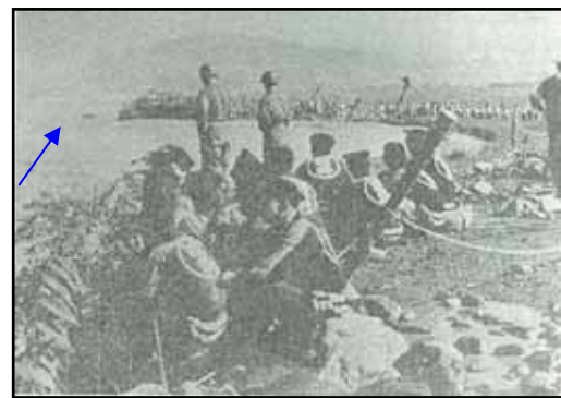
写真 4-15 犀川右岸明科地区付近の水防作業
