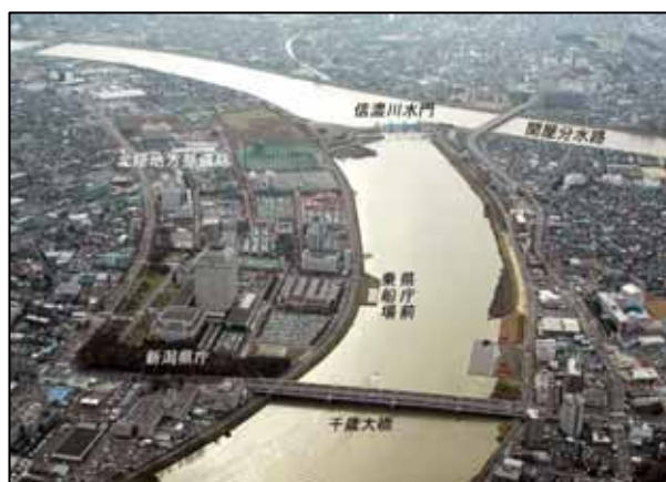
写真 11-6 信濃川水門と関屋分水路
