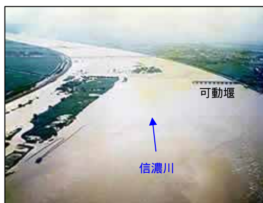
写真 4-39 大河津可動堰付近の様子
