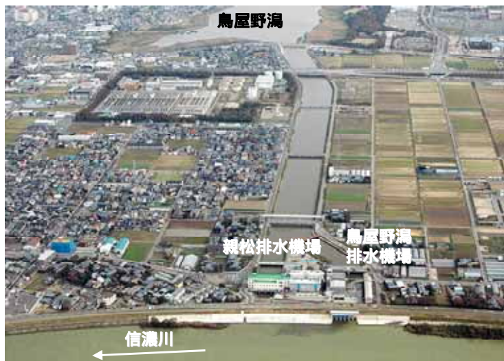
写真 11-7 鳥屋野濁排水機場
