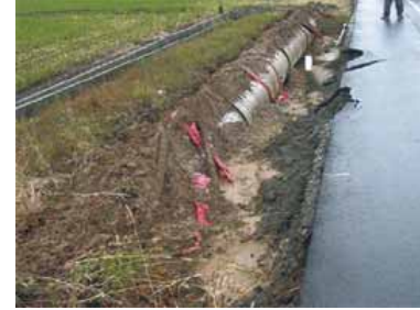
小千谷市西中 消流雪用水導水管破損
