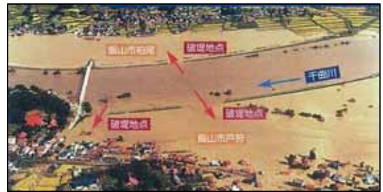
写真 4-36 千曲川の破堤状況
