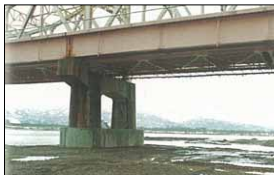
写真 4-78 長生橋橋脚補強工事
