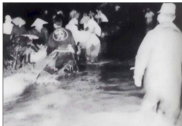
写真 4-18 水防作業の様子
