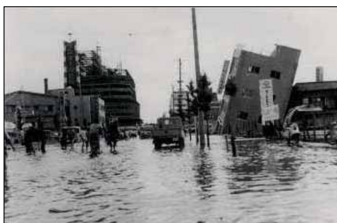
写真5-2 浸水した新潟市明石通り (地下水・土砂の噴出により、 地震直後は60cmの深さで浸水)
