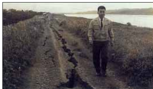
写真5-11 真野代地先の堤防亀裂
