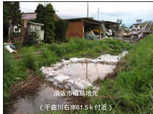
平成18年7月洪水堤防漏水状況
