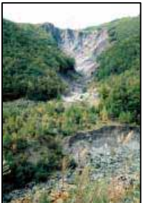
・焼岳下掘沢の崩壊地
