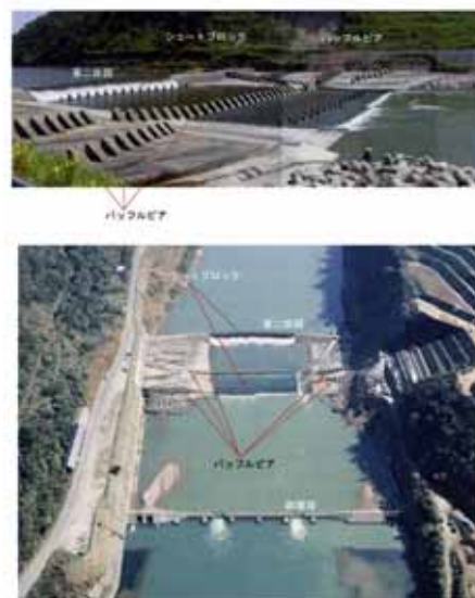
写真 4-67 バツフルピアの設置状況
