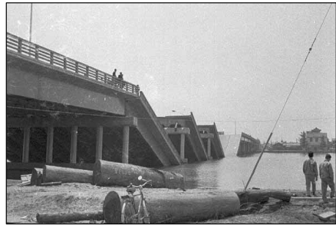
写真5-4 地震により落下した昭和大橋
