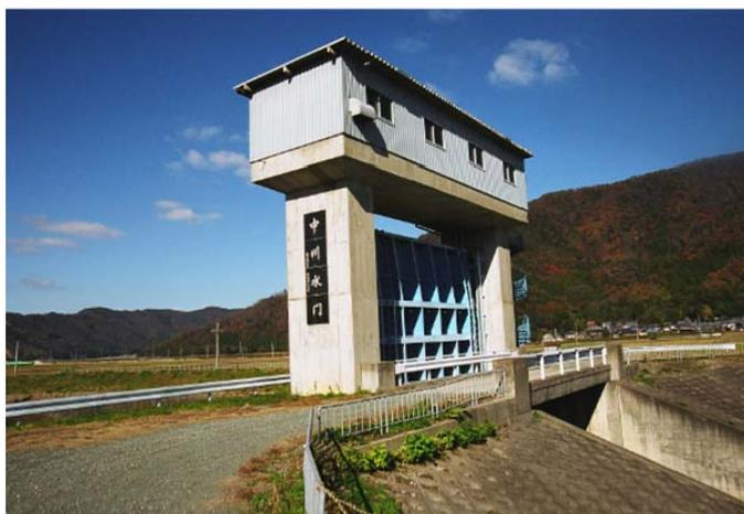
水門構造 : 鉄筋コンクリート函型
