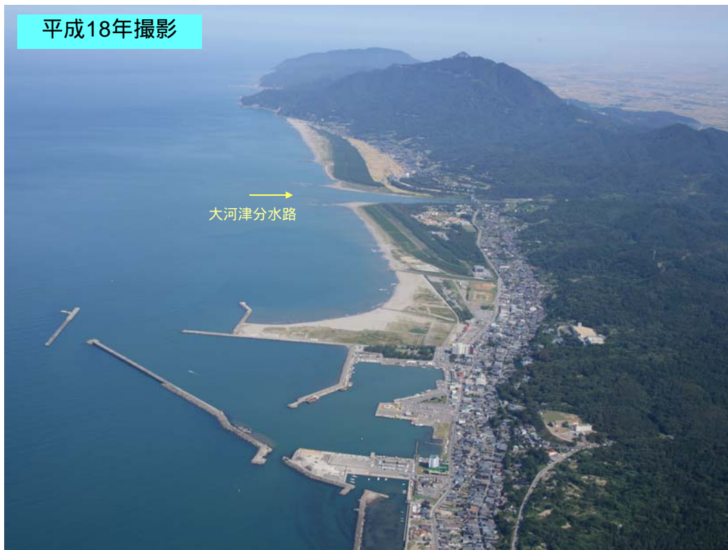
図 5-2 現在の大河津分水路河口の状況
