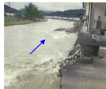
▲家屋の被災状況
