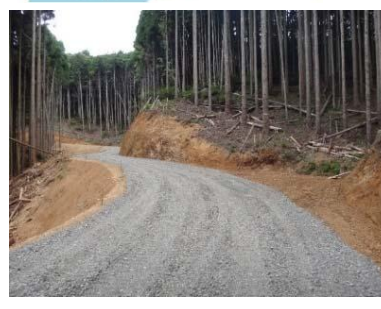
【森林整備：林道（整備）】
