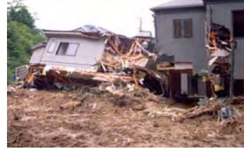
平成11年6月広島市 (写真提供:広島県砂防室)
