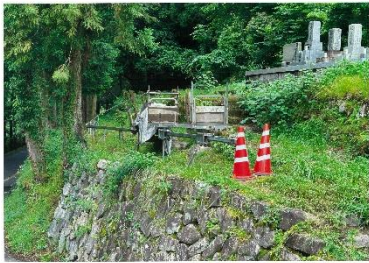
地質調査モノレール設置状況
